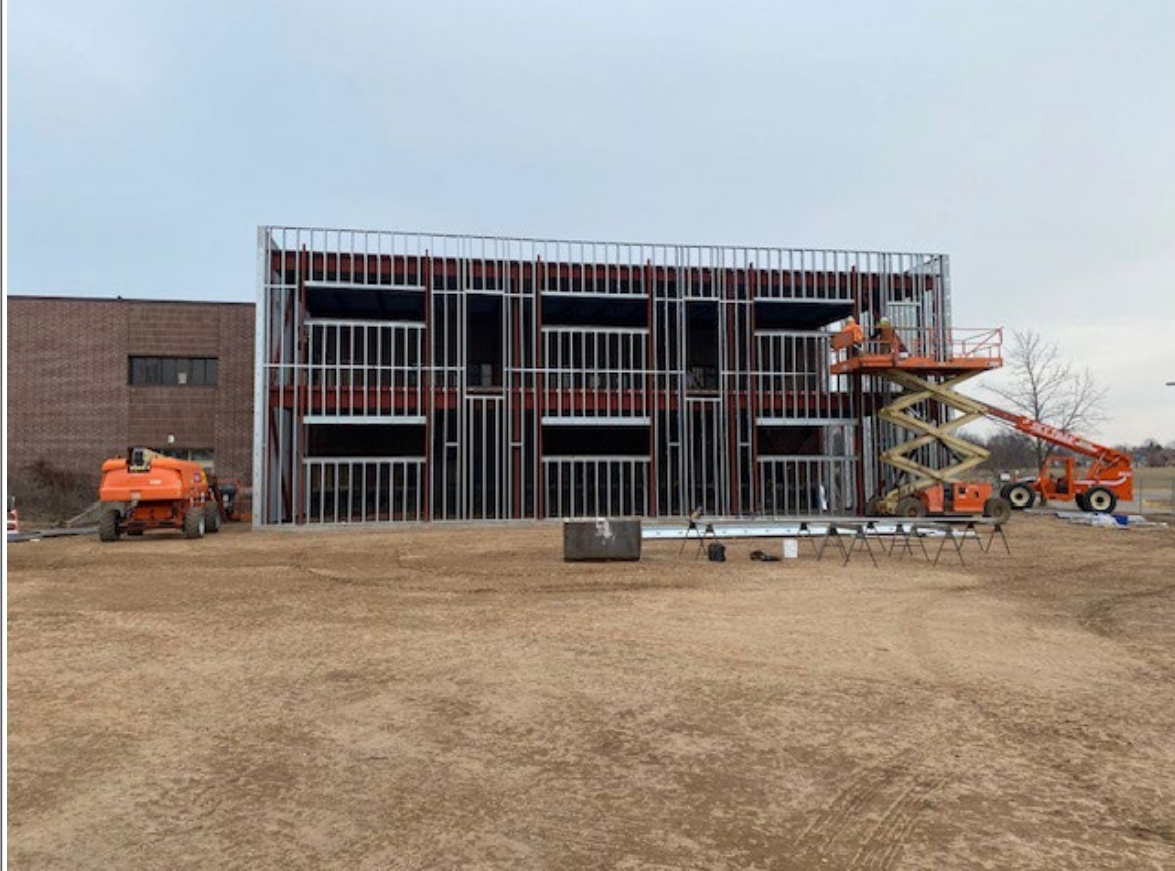
Structural stud framing area B
