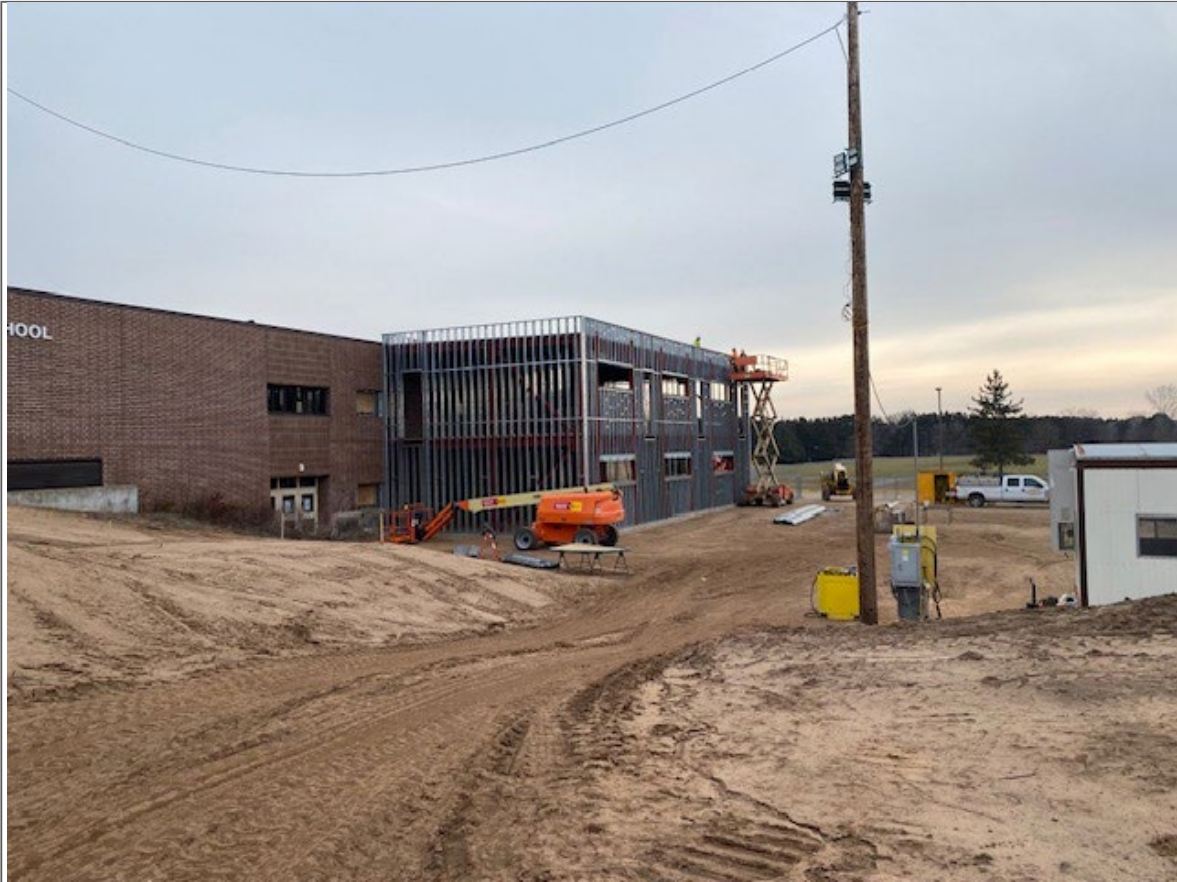
Structural stud framing area B
